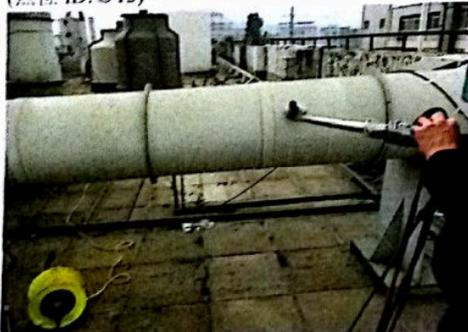
同利源 1#厂房 2F 东侧镀硬铬线铬酸雾喷淋塔出口
