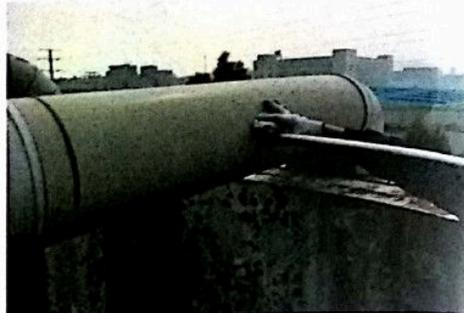
同利源 1#厂房 2F 东侧镀硬铬线铬酸雾喷淋塔进口
